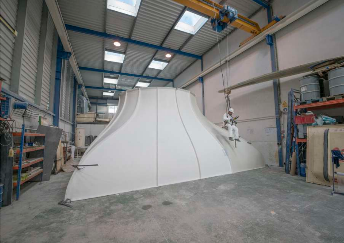
Atenas Túnel de Viento Construcción
